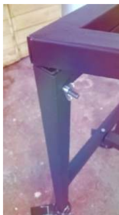
Figura 46 – Parafuso fixando quadro ao cavalete.
